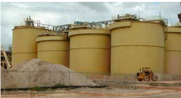
Agitadores com 200 HP, em tanques CIL c/ 18m dia.
